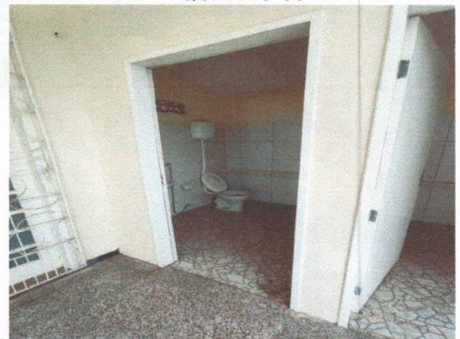
BANHEIRO DE SERVIÇO
