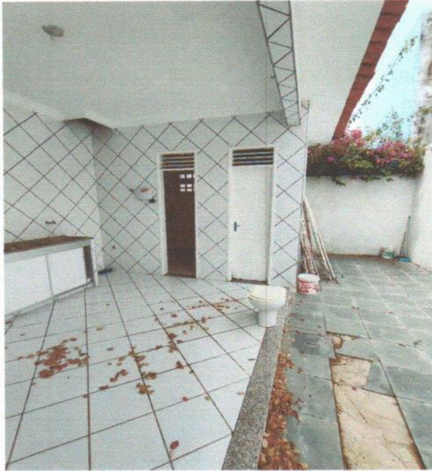
AREA DE SERVIÇO EXTERNA COM BANHEIROS
