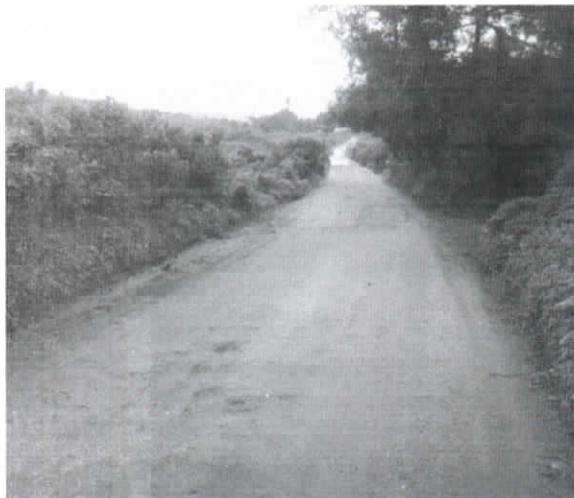
INICIO DO TRECHO DA 2ª ETAPA DA OBRA-COORD. UTM: 280248.46-X/9586786.51-Y
