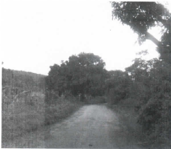
TRECHO DA 2ª ETAPA DA OBRA- COORD. UTM: 281523.40- X/9586928.64-Y
