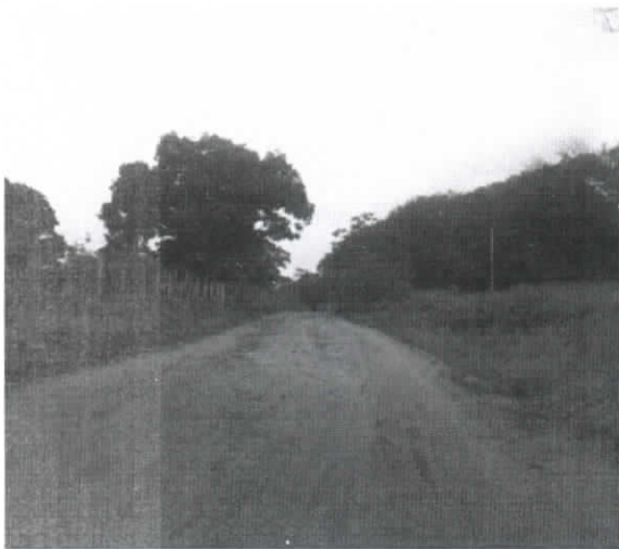
INICIO DO TRECHO DA 2ª ETAPA DA OBRA-COORD. UTM: 280571.56-X/9586796.77-Y
