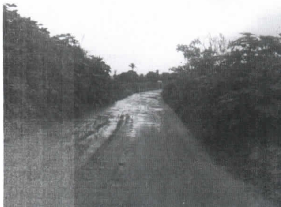
INICIO DO TRECHO DA 2ª ETAPA DA OBRA-COORD. UTM: 280356.48-X/9586800.21-Y
