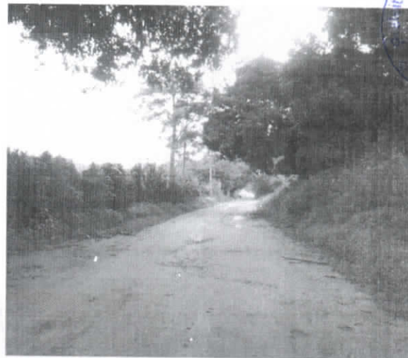
TRECHO DA 2ª ETAPA DA OBRA- COORD. UTM: 281646.64- X/9586963.35-Y
