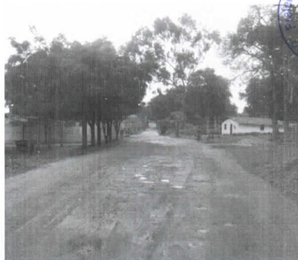
INICIO DO TRECHO DA 2ª ETAPA DA OBRA-COORD. UTM: 280657.97-X/9586797.84-Y
