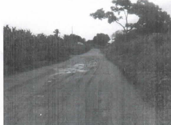
INICIO DO TRECHO DA 2ª ETAPA DA OBRA-COORD. UTM: 280486.81-X/9586806.86-Y
