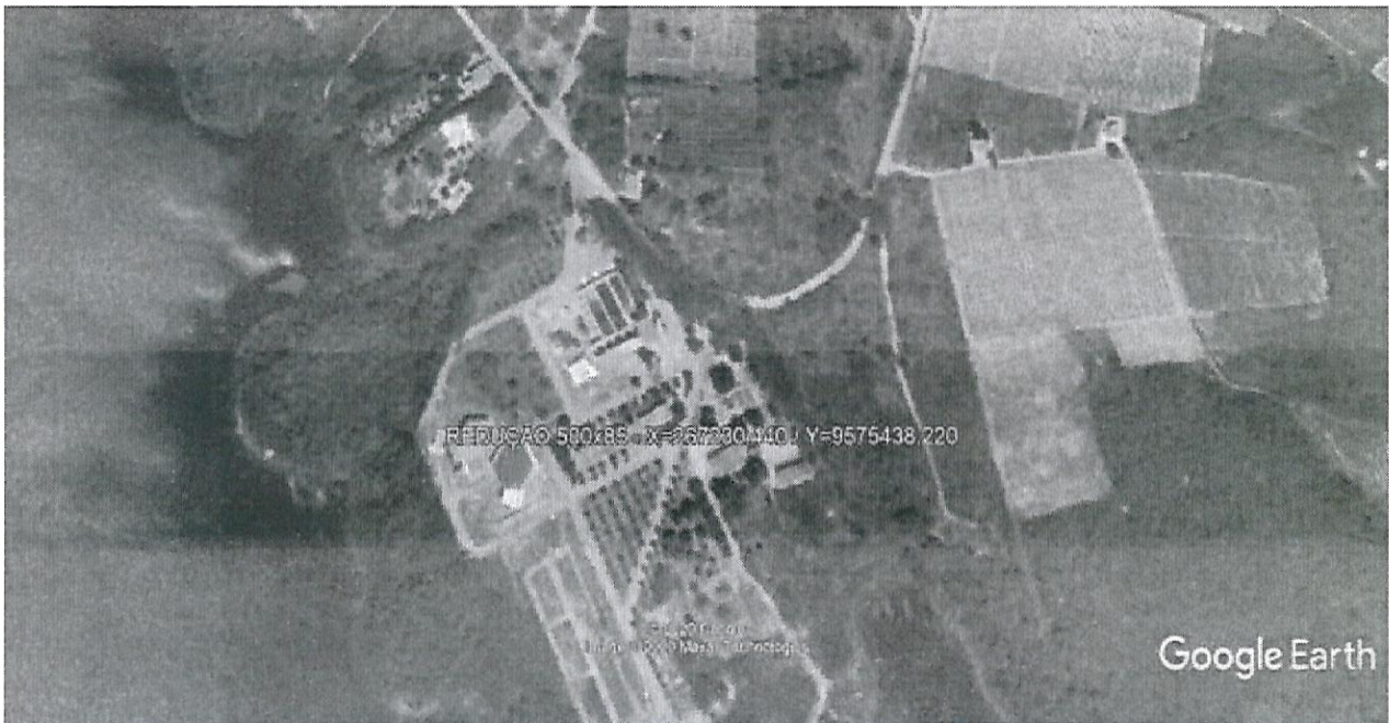
CAPTAÇÃO – REDUÇÃO 500 X 75mm NA ADUTORA DA CAGECE
