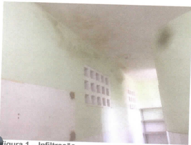
Figura 1 - Infiltração
