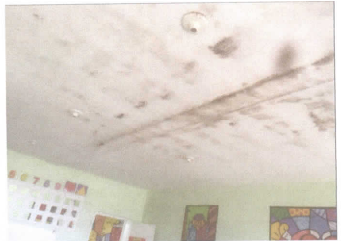
Figura 21 - Teto Sala de atividades
