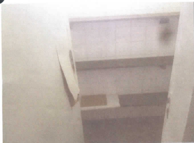
Figura 12 - Depósito da Cozinha
