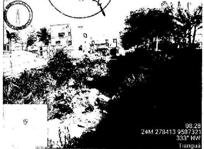
FOTO 08: SITUAÇÃO ENCONTRADA "IN LOCO" APÓS AS CHUVAS.
