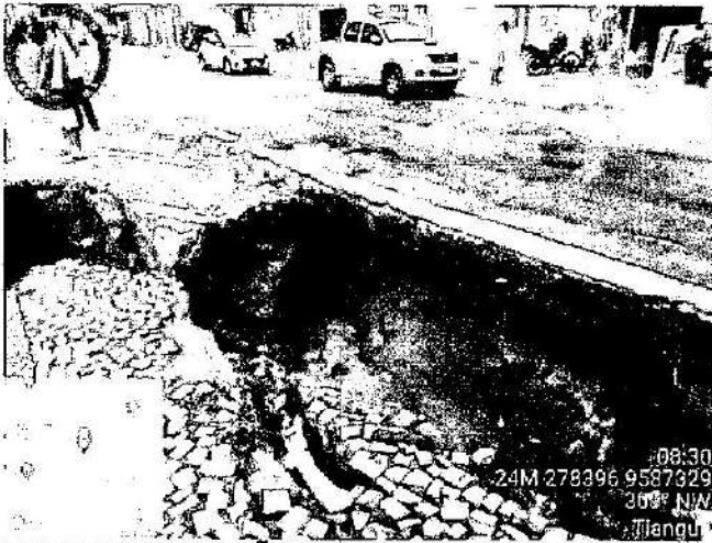
FOTO 05: SITUAÇÃO ENCONTRADA "IN LOCO" APÓS AS CHUVAS.
