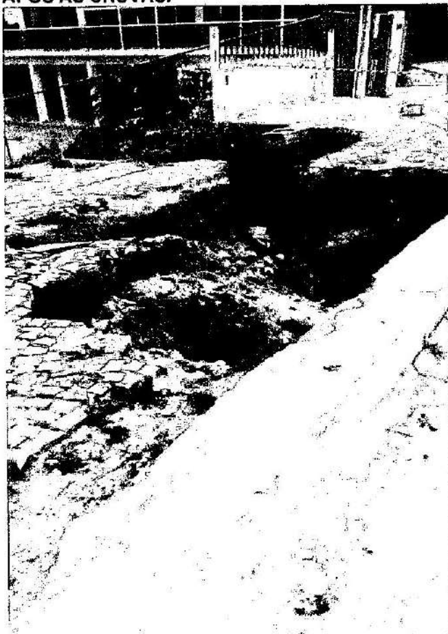
FOTO 02: SITUAÇÃO ENCONTRADA "IN LOCO" APÓS AS CHUVAS.
